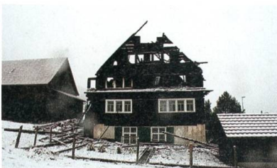
Das abgebrannte Haus im Ganten ist nicht mehr zu retten.
