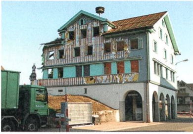
Abbruch des Gemeindehauses Nesslau.
