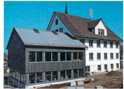
Büros der Gemeindeverwaltung in der ehemaligen Post Mogelsberg.
