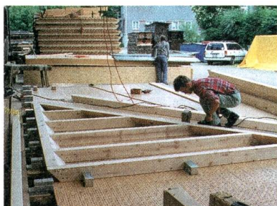
Auch die Fertigung eines montagebereiten Dachelementes bei Scherrer in Bütschwil darf als Präzisionsarbeit bezeichnet werden. Slg. Scherrer Holzbau.
