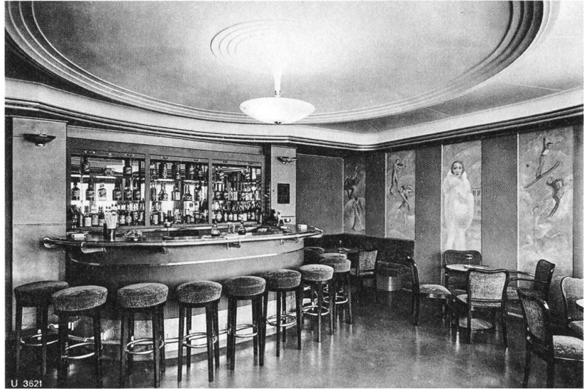
Hotel Sternen Unterwasser, Bar, Anbau West, 1935. Sammlung Autor.
