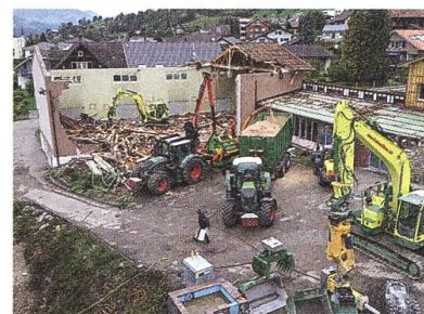
Abbruch der Turnhalle.
