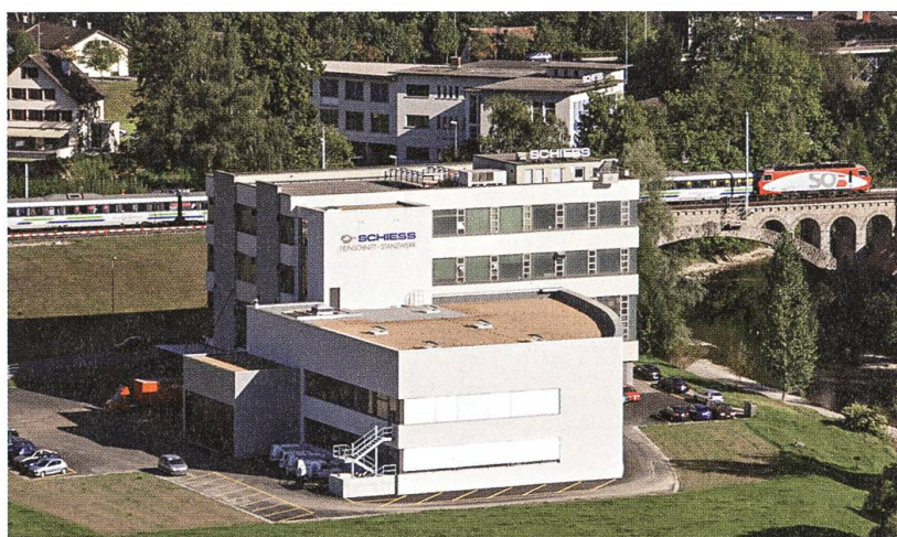
Der Neubau im Flooz 2009, angebaut an die im Jahr 1965 erstellte Fabrikanlage.
