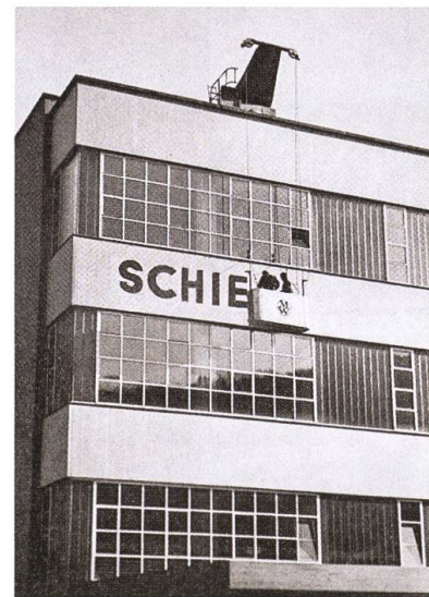
Die Fassadenreinigungsanlage dient auch der Beschriftung des Gebäudes.
