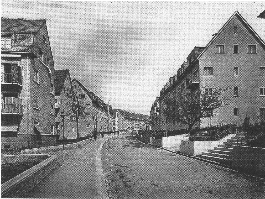
Abb. 2: Milchbuckquartier. Genossenschaftskolonien an der Stüssistrasse bilden weite, aber klar gefasste Strassenräume. (Baugeschichtliches Archiv der Stadt Zürich)
