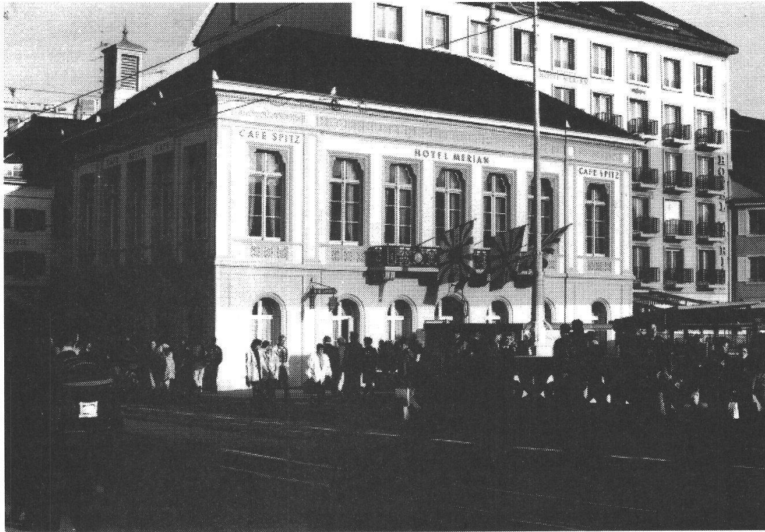
Eines der teuren Arbeitsrappen-Projekte war die Renovation des Café Spitz am Kleinbasler Kopf der Mittleren Brücke, prozyklisch durchgeführt in der guten Konjunktur der frühen 1970er Jahre. (Photo: Greta Schindler, Januar 1996)
