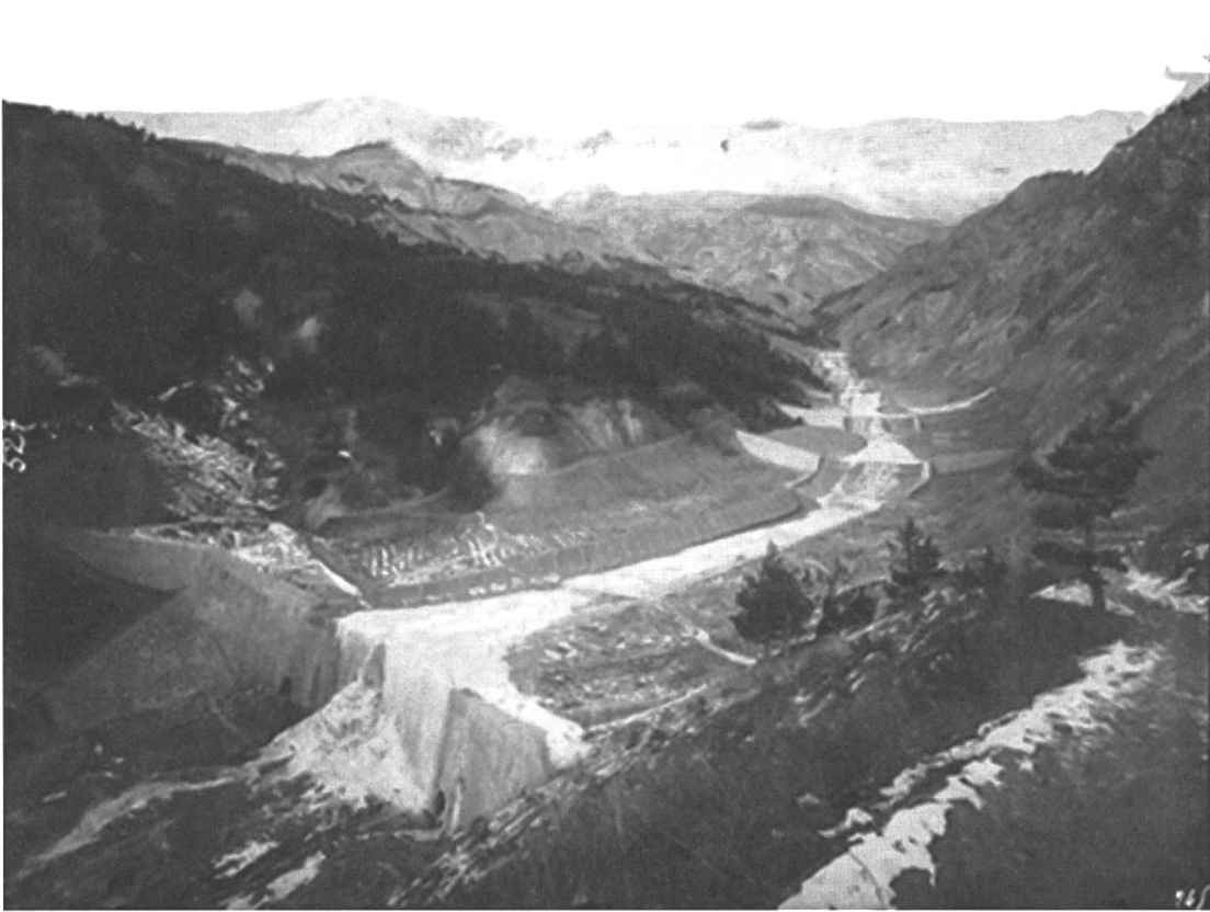
Fig. 1: Cliché des RTM, attestant des travaux réalisés pour canaliser les torrents. Source: Jean Paul Métaillé, Isabelle Richefort, L'Avalanche et le torrent. Les forestiers photographes de la montagne (1885–1940), Catalogue d'exposition, Toulouse 1990 .
