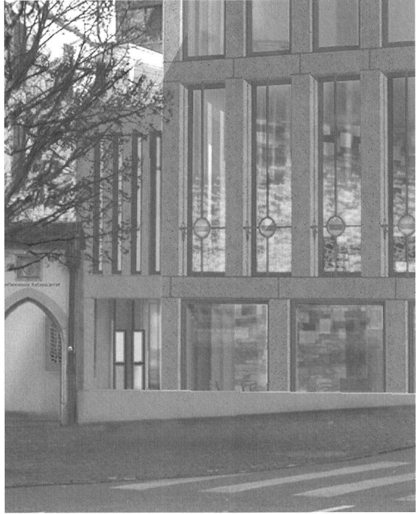
M. Sik, Stadthaus, Zug, 2003 Geätzte Glasscheiben sind ein dem hiesigen Glaserhandwerk entsprechendes und zugängliches Verfahren. Andernorts kommen auch schleifen, blasen, einschmelzen und ritzen in Betracht. Glasmalerei mit Bleiverbindungen ist nur als Zusatzscheibe zum IV-Glas möglich.
