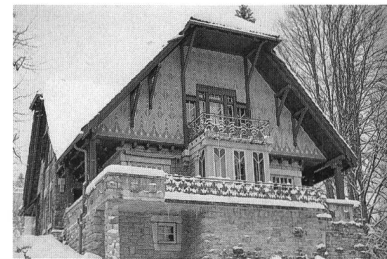
Villa Fallet in La Chaux-de-Fonds, Le Corbusier, 1907
