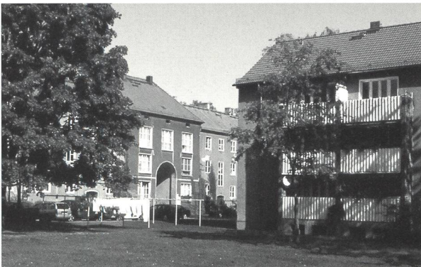
Wohnkomplex III in Eisenhüttenstadt, 1954-1958 (Aufnahme 2003)
