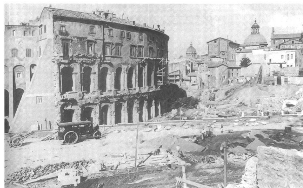
Marcellus Theater während der Restaurationsarbeiten, Rom, 1929
