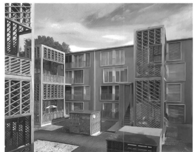
Frank Zierau, Kolonie Burriweg mit Ersatzneubauten, Zürich, 2002
