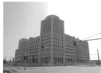
Aldo Rossi, Rohbau ruine Landsberger Allee , Berlin, Foto, 2004
