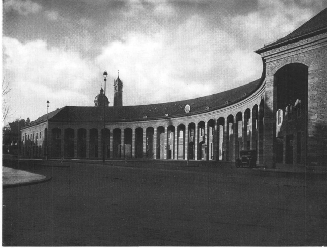
Gebrüder Pfister, Bahnhof Enge , Zürich, 1925/26, Foto.
