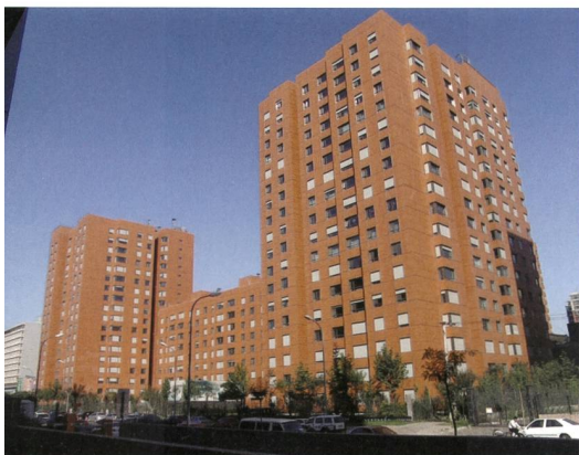
Architekt: Manfred Wöhr, Technologie: Keller Technologies AG, TIPTOP-Appartements , Beijing, in Betrieb seit März 2003, Zustand 2006, Foto von Bruno Keller.
