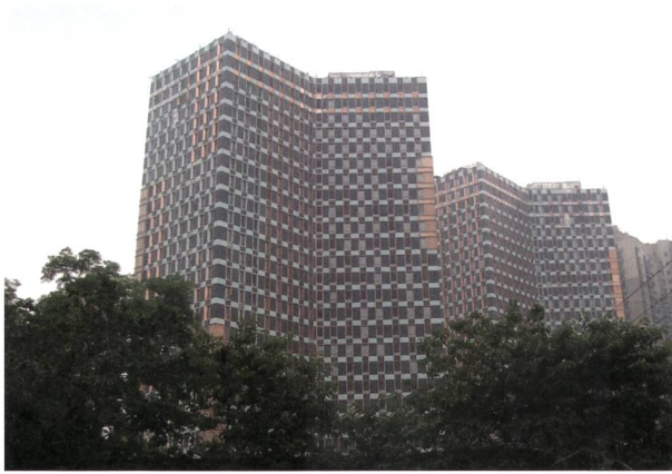
Architekt: Baumschlager & Eberle, Technologie: Keller Technologies AG, MOMA-International Apartments, Beijing, in Betrieb seit März 2006, Zustand Juli 2006, Foto von Tian Yuan.
