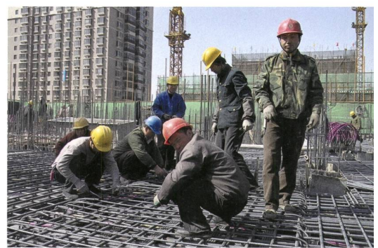
Architekt: Baumschlager & Eberle, Technologie: Keller Technologies AG, Baustelle der POPMOMA-Apartments , Beijing, Rohbauarbeiten Juli 2006, Foto von CC ETHZ.
