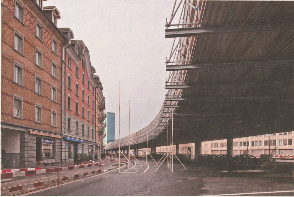
Baugespann zum Zürcher Nagelhaus Gruppe Baugespann, Januar 2011. Erläuterungen auf S. 57.
