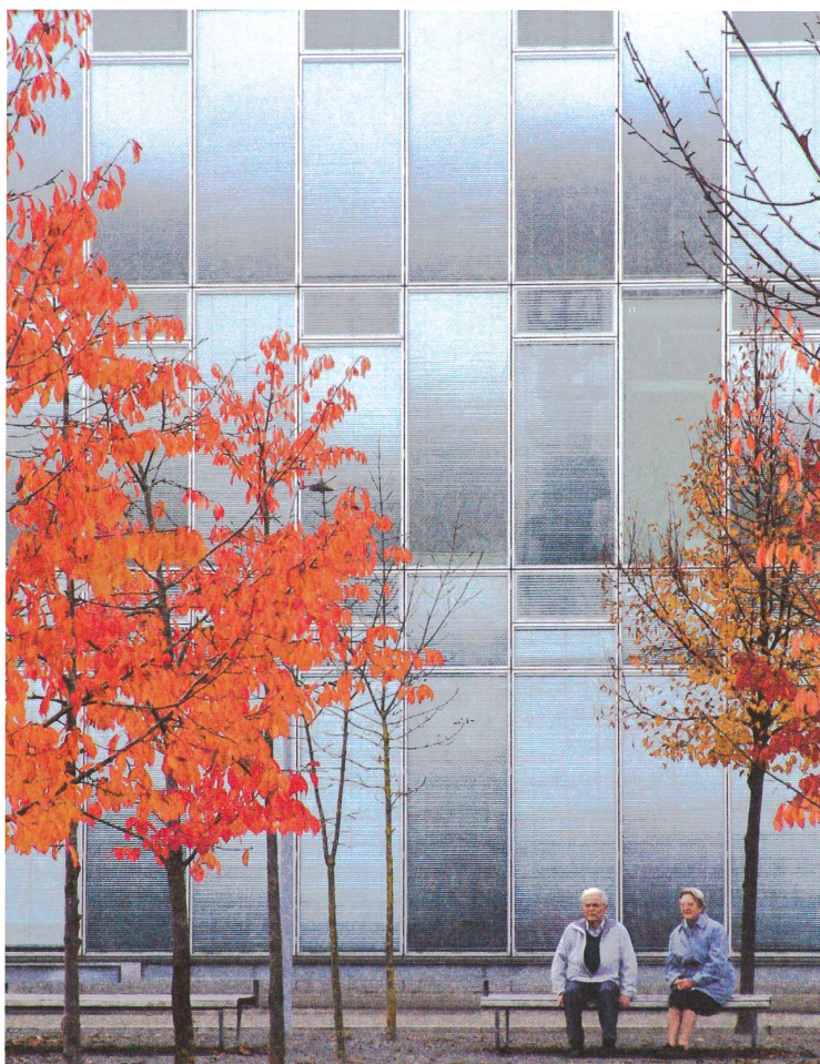
fig. e Überbauung Neu-Oerlikon © Samuel Tobler.
