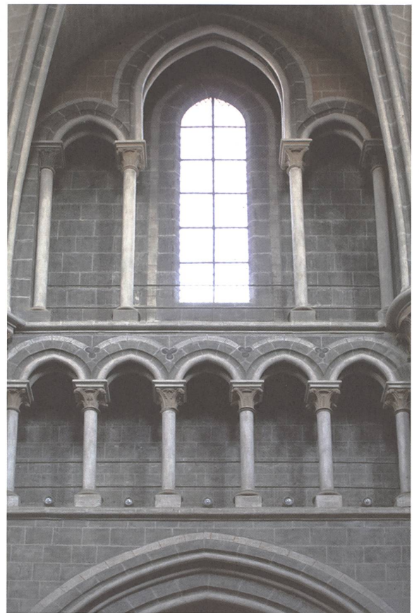
fig. 1 Nef, triforium et fenêtre-haute. Photographie : Dave Lüthi
