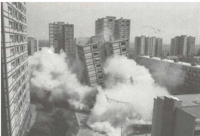
fig. f Demolition of the tower 106, Les Minguettes, Lyon, France, 1983 © Bibliothèque Municipale de Lyon
