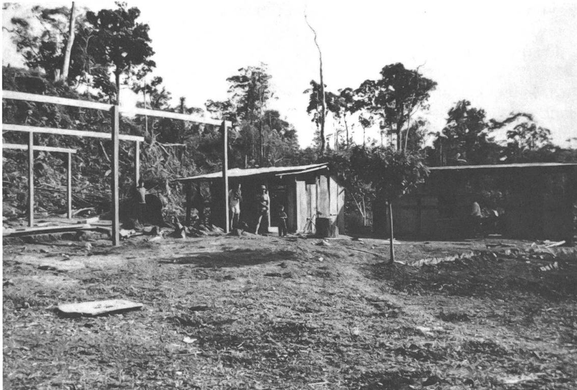
Peruanische Kolonisten, die in der Nähe des Pongo de Mainique, im Siedlungsgebiet der Matsigenka, Häuser errichten. Diese gehören dem Bootsführer Miguel Ugarte, der seinen Wohnsitz in Quiteni ( Ki'teni ) hat.
