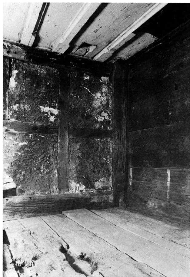
Abb. 35 Zug, Haus Dorfstrasse 8. Bohlenständergebäude um 1450. Blick in die Nordwestecke der Stube im Erdgeschoss. Die Fachwerk- wand gehört einer jüngeren Bauphase an.
