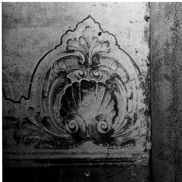
Abb. 17 Baar, Kirche der Internatsschule Walterswil. Dekorationsmalerei vor der Restaurierung.
