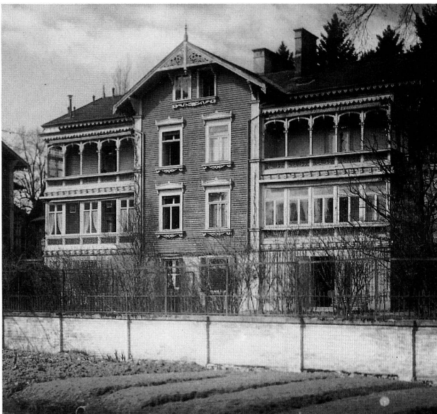
Abb. 24 Cham, Luzernerstrasse. «Kolonialstil»-Häuser, 1876 als Direktionsvillen der Milchsiederei nach amerikanischen Konstruktionsprinzipien erbaut. Abbruchgefährdet.
