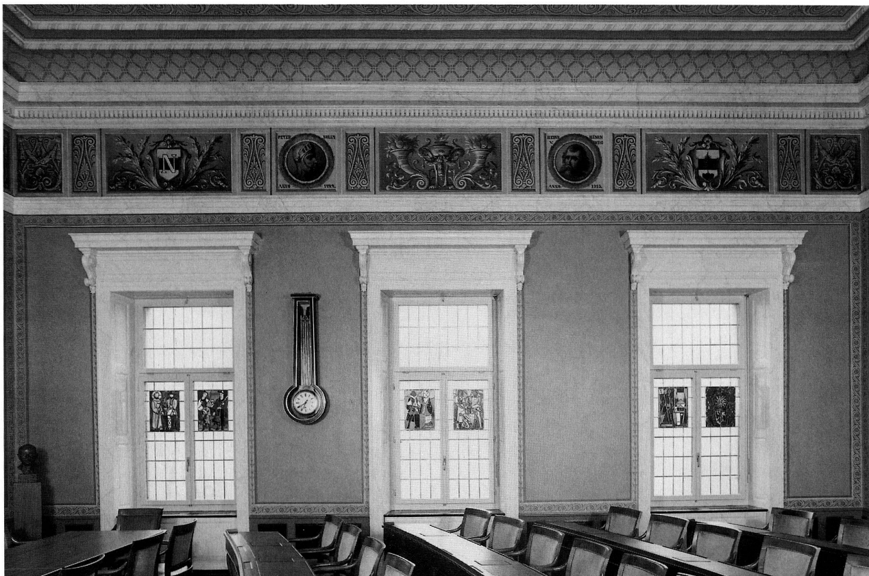
Abb. 9 Zug, Regierungsgebäude. Ostwand des Kantonsratssaales mit wiederhergestellten Fensterrahmen und renovierter Wandbemalung. Die passende «Pendulette branlante» ist ein Geschenk der Stadt Zug.
