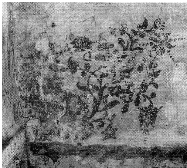
Abb. 7 Zug, Ehemaliges Kornhaus (neue Stadtbibliothek). Dekorationsmalerei im 1. Stock, jetzt hinter Vormauerung, Mitte 16. Jahrhundert.
