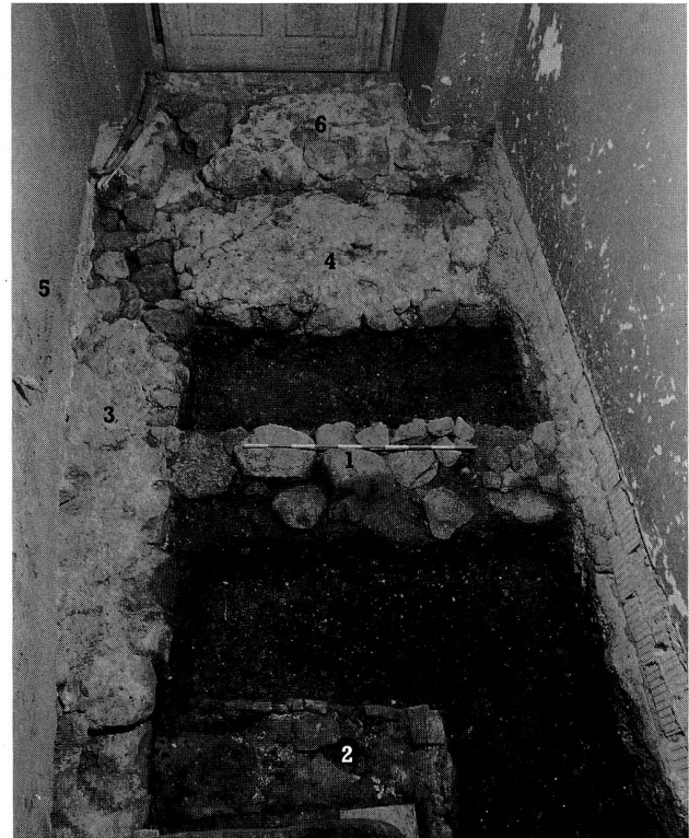
Abb. 14 Zug, Haus Untergasse 3. 1 Trockenmauer (I), 2 Herdstelle (I), 3/4 Fundamentwinkel (vermutl. 15. Jh.), 5 Südmauer, 6 Westmauer (16. Jh.).
