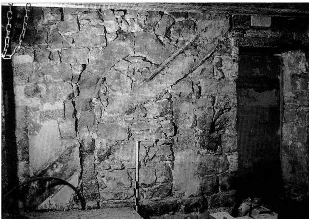
Abb. 25 Zug, Chaibenturm. Südfassade. Spitzbogenportal, 14. Jh.
