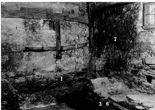
Abb. 32 Zug, Haus Zeughausgasse 19. EG Ostraum. Blick nach Nordosten. 1 Schwellbalken (I), 2 Rähmbalken (I), 3 Bodenreste (I), 4 Fachwerkwand (II), 5 (Aufhöhung (II), 6 Bodenreste (II), 7 Ostmauer (evtl. III), 8 neuzeitl. Gerbegrube.
