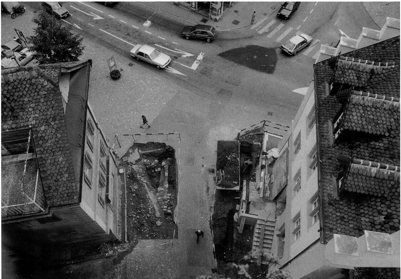
Abb. 2 Zug, Kolinplatz. Leitungsgräben vor dem Zyturm. Freigelegte Mauerreste der alten Brücke über dem Stadtgraben, 13. September 1985 (vgl. Objekt Nr. 195).
