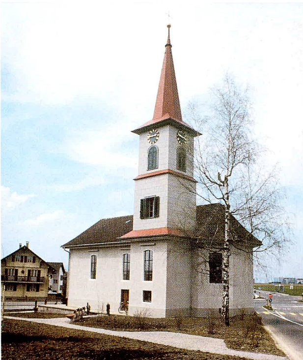
Abb. 10 Holzhäusern. Kapelle St. Wendelin. Äusseres nach der Restaurierung und Wiederherstellung der ursprünglichen Farbabstufung am Turm.
