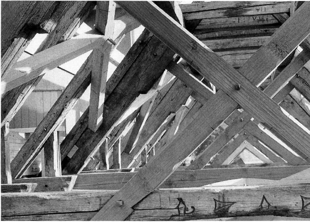
Abb. 17 Zug. Alte Steinhauserbrücke. Ergänzierter Dachstuhl unten die angeschnittene Jahrzahl 1712.
