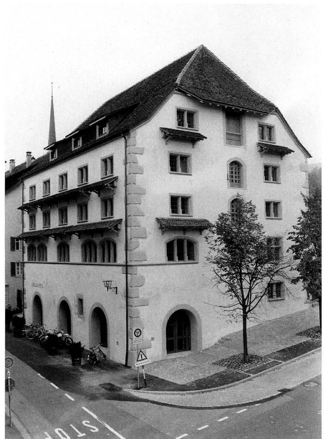
Abb. 16 Zug. Ehemaliges Kornhaus jetzt Stadt- und Kantonsbibliothek. Zustand nach der Restaurierung mit wiedergeöffneten Aufzugstüren und wiederhergestellter Befensterung des 16. Jahrhunderts. Die Tore im Erdgeschoss sind neu.
