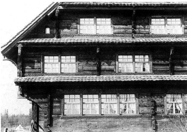
Abb. 14 Steinhausen. Haus Tann. Detail aus der restaurierten Fassade mit wiederhergestellten Fensterwagen und Sprossenfenstern nach aufgefundenem Vorbild.
