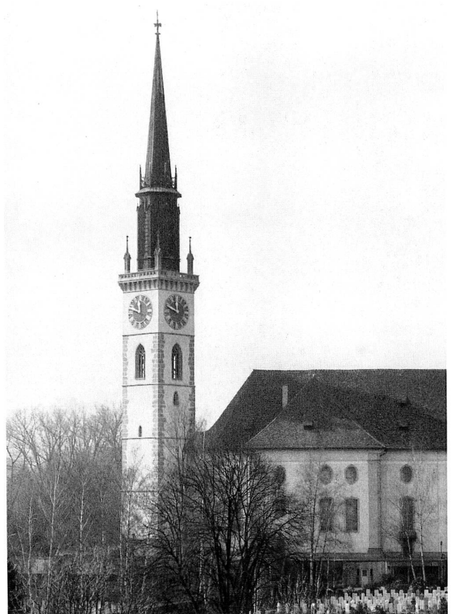
Abb. 6 Cham. Kirche St. Jakob. Zustand des Turmes nach der Renovation von 1987, entsprechend dem 1959 geschaffenen «materialechten» Zustand.
