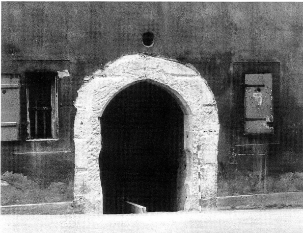
Abb. 41 Zug, Ägeristrasse 2. Rundbogenportal mit späteren Ausbuchtungen für die Weinfässer.
