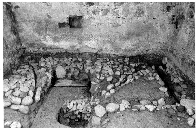
Abb. 26 Zug, Dorfstrasse 8. Raum 2, Drainage.
