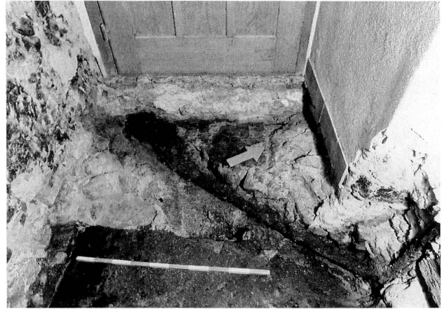
Abb. 24 Zug, Untergasse 7, Erdgeschoss, Eingangspartie. Blick nach Westen. Fundametrest der ehemaligen Westmauer.
