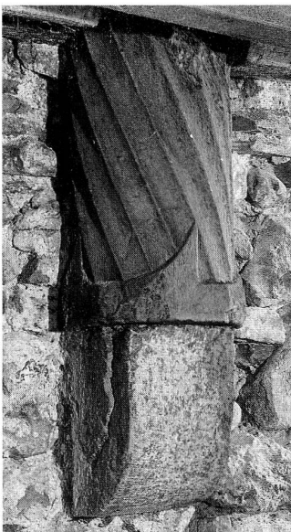
Abb. 37 Zug, Graben 12. Keller, Gotischer Fensterpfosten in sekundärer Verwendung.
