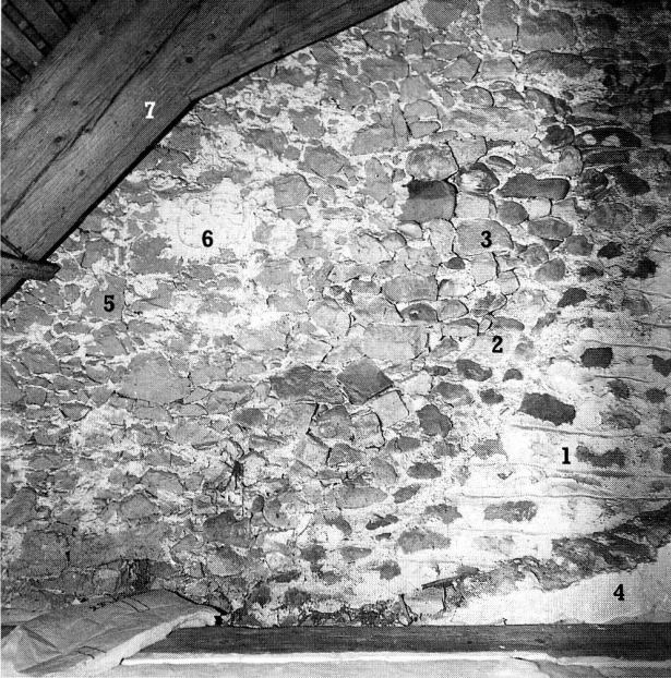
Abb. 67 Ansicht an den nördlichen Teil des Ostgiebels im Dachstock. 1 Ostgiebelwand mit Fugenstrichverputz, Kirche I, 2 Aufhöhung, Kirche II, 3 Aufhöhung, Kirche III, 4 Giebelvormauerung, Kirche III, 5 Giebelaufhöhung, Kirche VI, 6 Verputzmedaillon 1732, Kirche VI, 7 Dachstock, Kirche VII.
