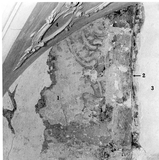
Abb. 90 Nördliches Gewände des Chormittelfensters hinter dem Hauptaltar der Kirche VII. 1 Vormauerung Chorostwand Kirche III, darauf Malereien um 1660, Kirche IV, 2 linke Laibung des Mauerwerkfensters, Kirche II und III, 3 Zumauerung von 2, Kirche VII, 4 Decke zur Kirche VII.
