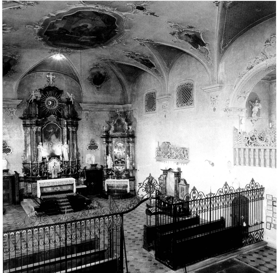
Abb. 98 Blick in den Chorraum Kirche VII, Zustand bis 1972.
