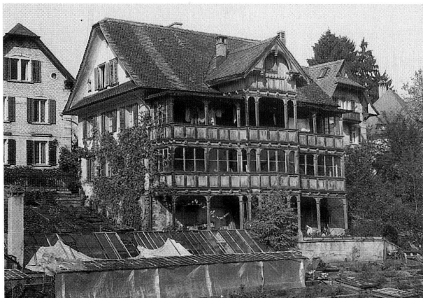
Abb. 8 Zug, Löberenstrasse 4. Wohnhaus vor dem Abbruch 1987.
