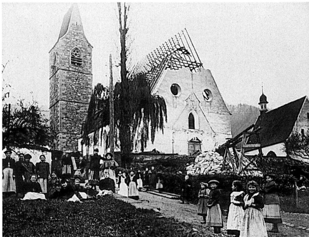
Abb. 41 Alt St. Michael: Abbruch.
