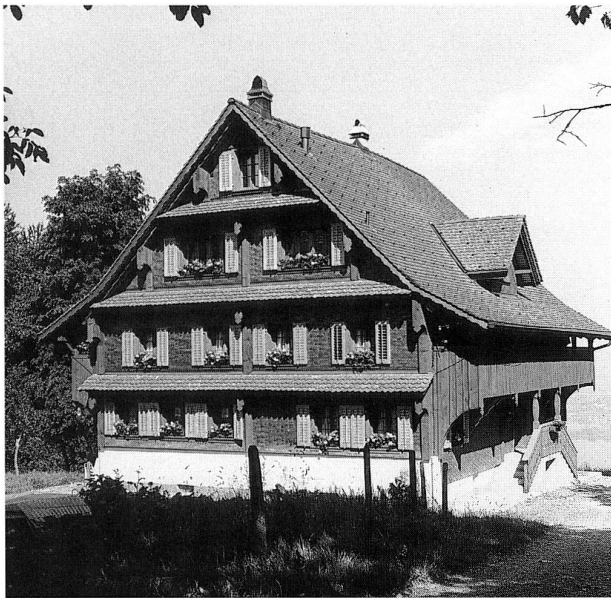
Abb. 26 Zug, Klosterhof. Bauernhaus nach der Restaurierung 1988.
