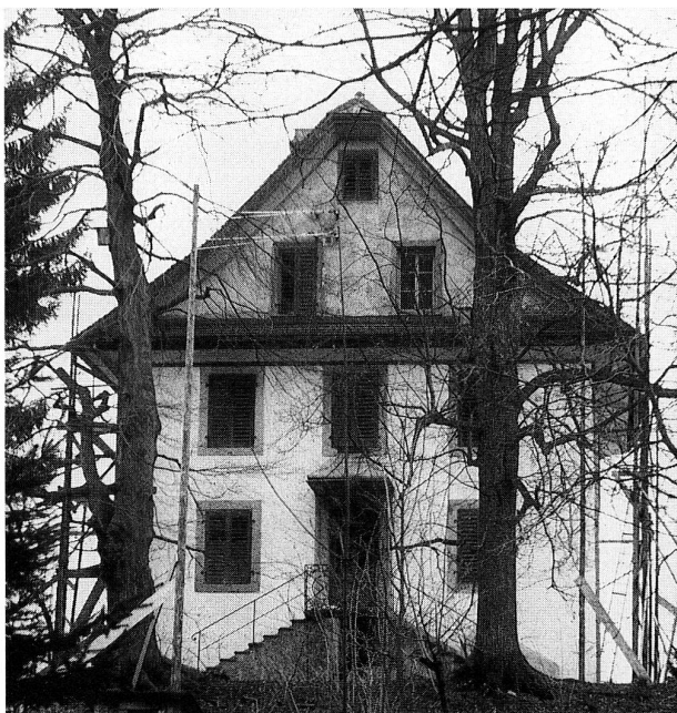
Abb. 25 Zug, Hasenbühl. Der Landsitz «Hasenbühl», 1825-1826 von Gardehauptmann Josef Anton Sidler erbaut.
