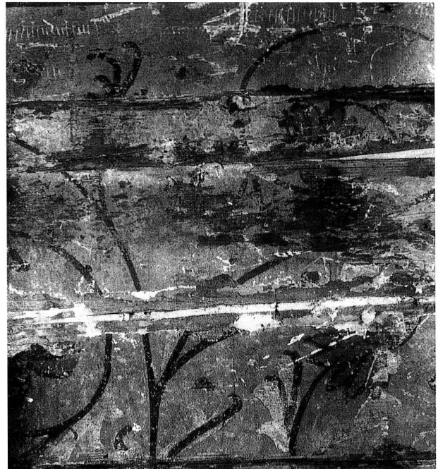
Abb. 11 Menzingen. Rickenbach-Haus, Hochparterre, Nordostraum. Bohlenwand mit Rankenmalerei.
