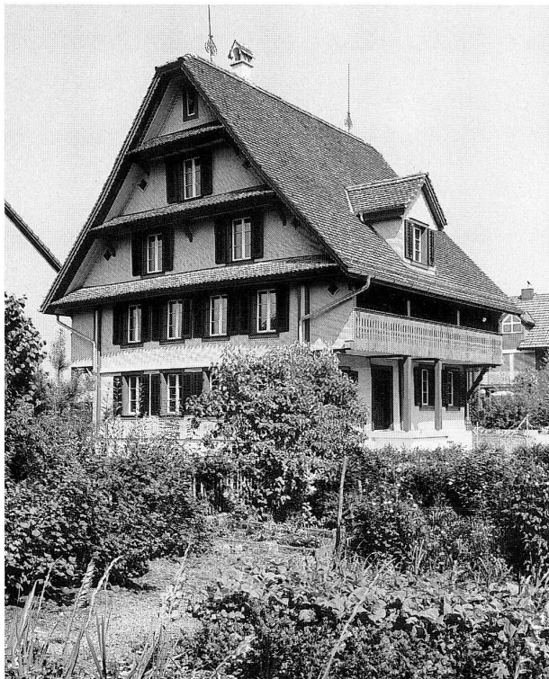
Abb. 19 Zug, Chamerstrasse 118. Wohnhaus nach der Aussenrestaurierung 1988.
