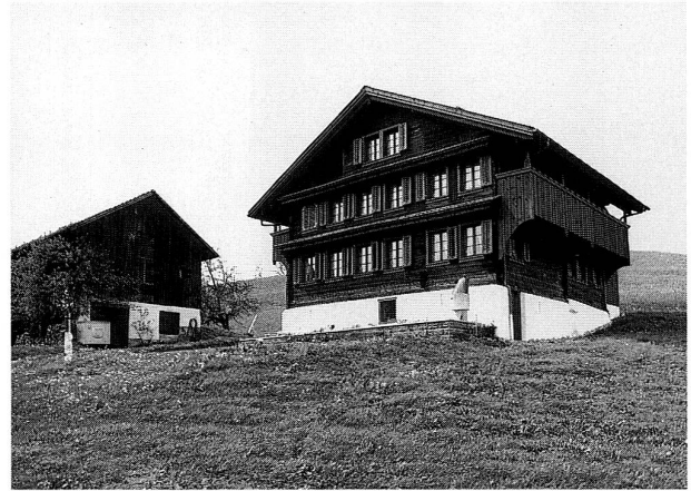
Abb. 15 Unterägeri, Unterzittenbuch. Bauernhaus nach der Restaurierung und Rekonstruktion des originalen Tätschdaches.
