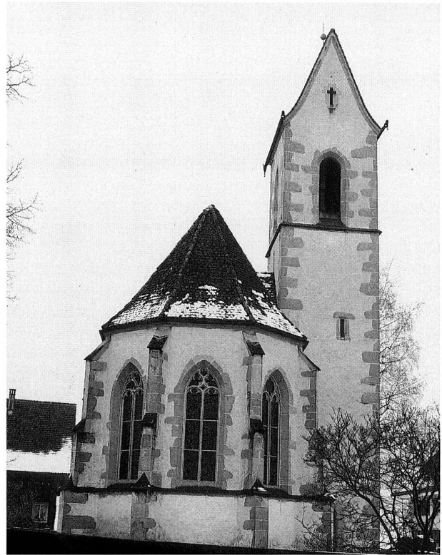
Abb. 67 Hünenberg, Kirche St. Wolfgang. Die Wallfahrtskirche von Osten. Zustand nach 1946 und vor 1988.
