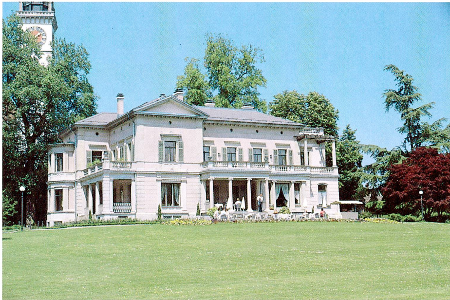
Abb. 62 Cham, Vilette. Südfront nach der Restaurierung.
