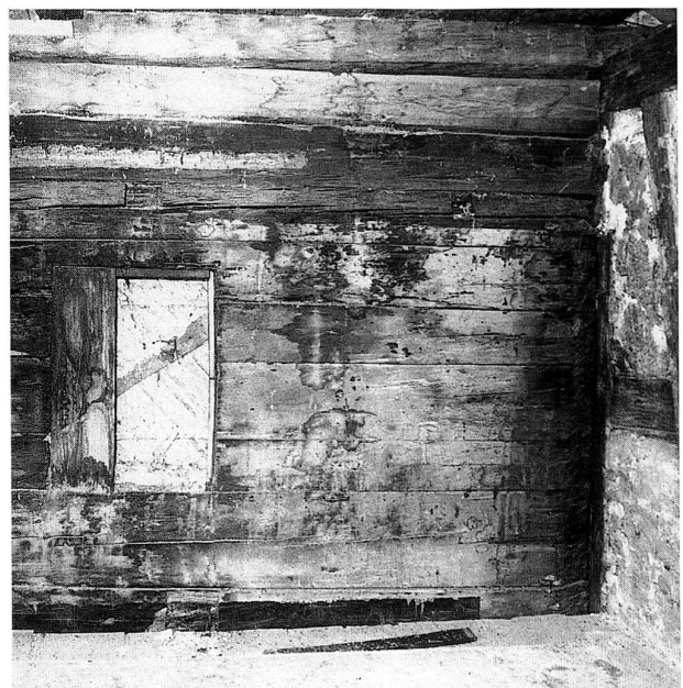
Abb. 12 Menzingen. Rickenbach-Haus. 1. Obergeschoss, ursprüngliche Südwand mit später verschlossenem und aufgegebenem Fenster. Ansicht von Norden.
