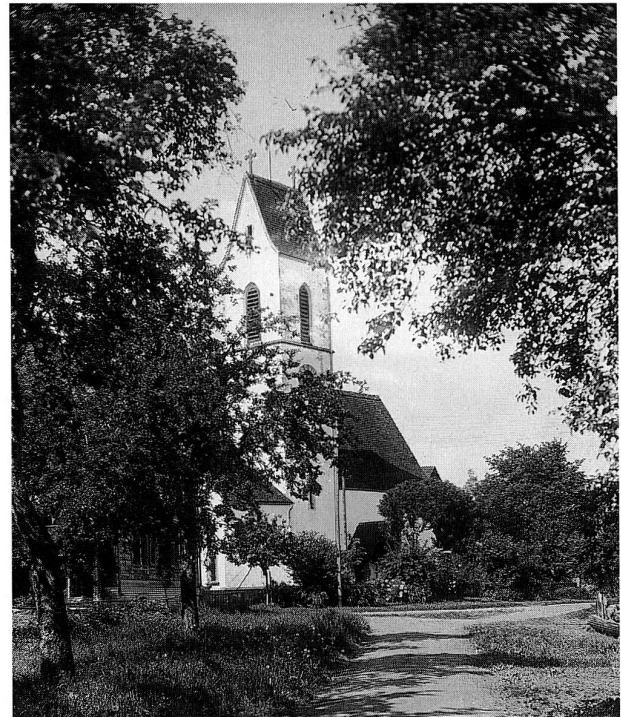
Abb. 68 Hünenberg, Kirche St. Wolfgang. Die Wallfahrtskirche von Nordosten. Zustand nach 1904 und vor 1946.
