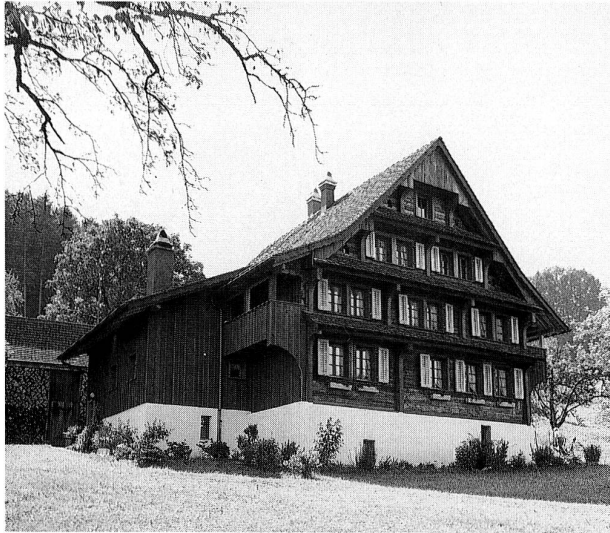
Abb. 27 Zug, Unterhof. Bauernhaus nach der Restaurierung 1988.
