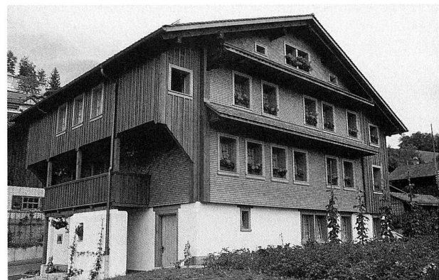
Abb. 9 Oberägeri, Schwerzelweg 2. Ansicht von Südwesten nach der Restaurierung, 1989.
