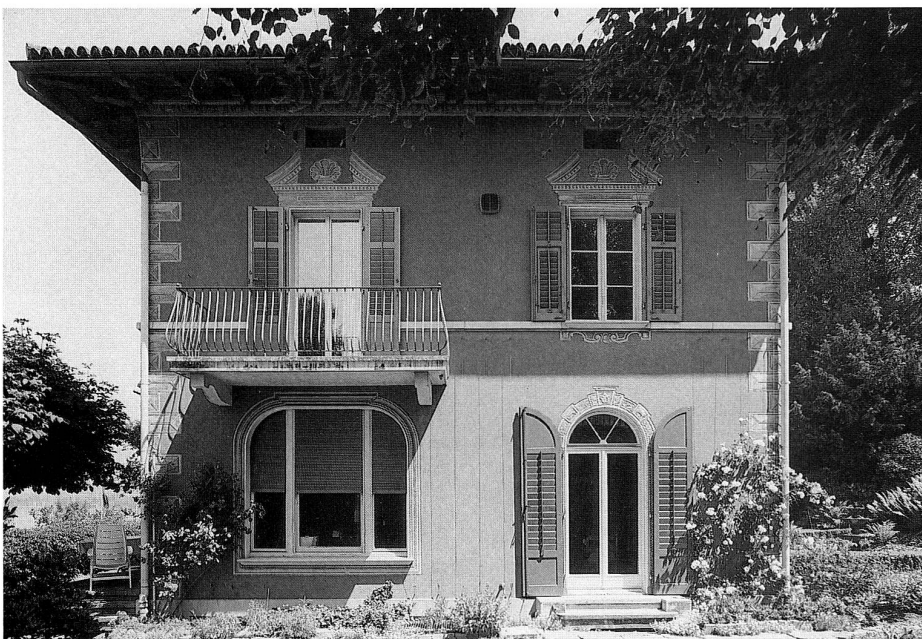
Abb. 13 Zug, Artherstrasse 29, «Casa Rossa». Seitenfassade von Süden, 1989.
