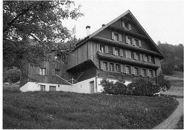
Abb. 8 Oberägeri, Oberbüel. Ansicht von Westen nach der Restaurierung, 1989.
