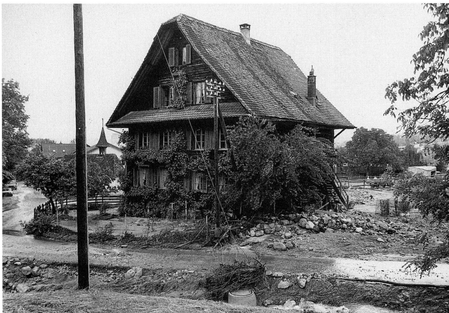
Abb. 4 Baar, Inwil, Talacher- strasse 27. Ansicht von Süd- osten vor der Restaurierung, sichtbar sind die Schäden des Unwetters vom 17. Juni 1986.
