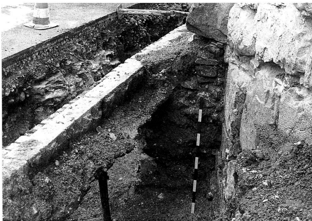
Abb. 10 Zug, Pulverturm. Blick Richtung Osten an den Pulverturm, Leitungsbauarbeiten 1991. Rechts Pulverturm mit freigelegtem nördlichen Maueransatz, links Fortsetzung Stadtmauer gegen Norden.
