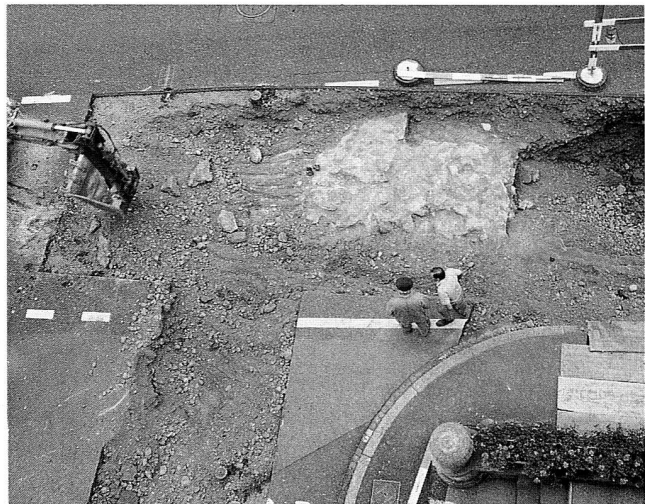
Abb. 5 Zug, Oberwilertor. Blick auf die geöffnete Zugerbergstrasse von Norden, 1983. Bildmitte Mauerreste von Stadtmauer (rechts) und Oberwilertor (links).
