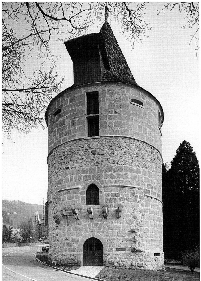
Abb. 8 Zug, Pulverturm. Ansicht von Nordwesten; Zustand 1992.
