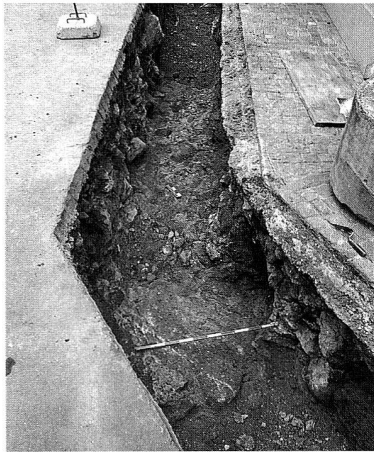
Abb. 25 Zug, Geissweid und St. Antonsgasse. Blick von Süden auf die 1990 festgestellte, abgewin- kelte Mauerfront (Innen- seite Stadtmauer) in der St. Antonsgasse. Foto nach Teilentfernung des Befundes für Leitungs- arbeiten.
