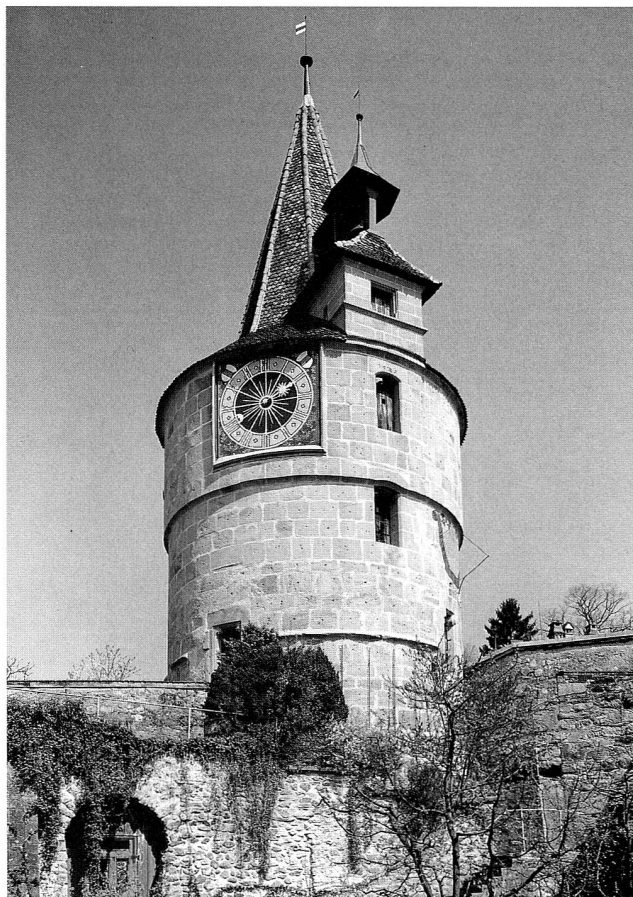
Abb. 22 Zug, Kapuzinerturm. Ansicht von Südwesten, Zustand 1991.
