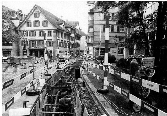
Abb. 1 Zug, Zeughausgasse. Blick Richtung Norden auf geöffneten Leitungsgräben, 1990. Das Foto illustriert eindrücklich die Schwierigkeiten archäologischer Untersuchungen bei derartigen Bauarbeiten.
