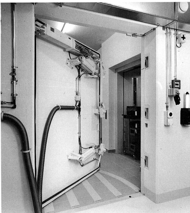
Abb. 7 Verwaltungsgebäude 1, 1. Untergeschoss. Blick vom Magazin C durch das geöffnete Panzertor zum internen Treppenhaus mit Lift. Das pneumatisch angetriebene Panzertor wird durch einen Schlüsselschalter bedient.
