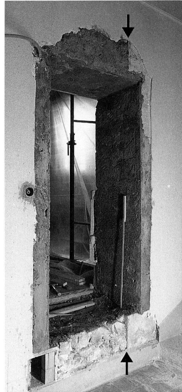
Abb. 8 ◁ Zug, Kloster Maria Opferung: Blick von Südwesten auf die wohl ursprüngliche Südwestecke der Kirche (Pfeile) mit bereits wieder verschalttem Türdurchbruch im Erdgeschoss.
