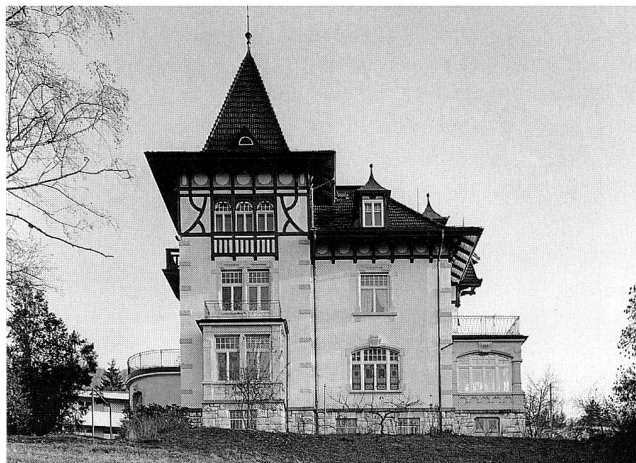
Abb. 2 Villa Hongkong, Zug. Ansicht von Westen nach der Aussenrestaurierung 1987.
