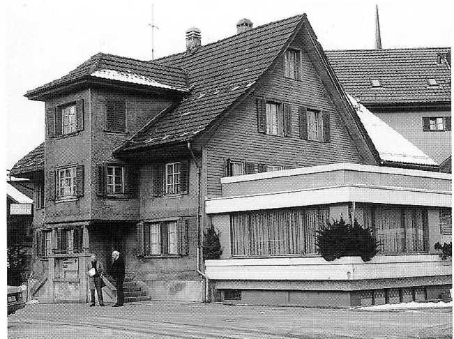
Abb. 12 Menzingen, Restaurant Ochsen, Neudorfstrasse 11. Blick auf die Südostecke mit dem modernen Flachdach-Anbau rechts; Zustand vor dem Abbruch Februar 1992.
