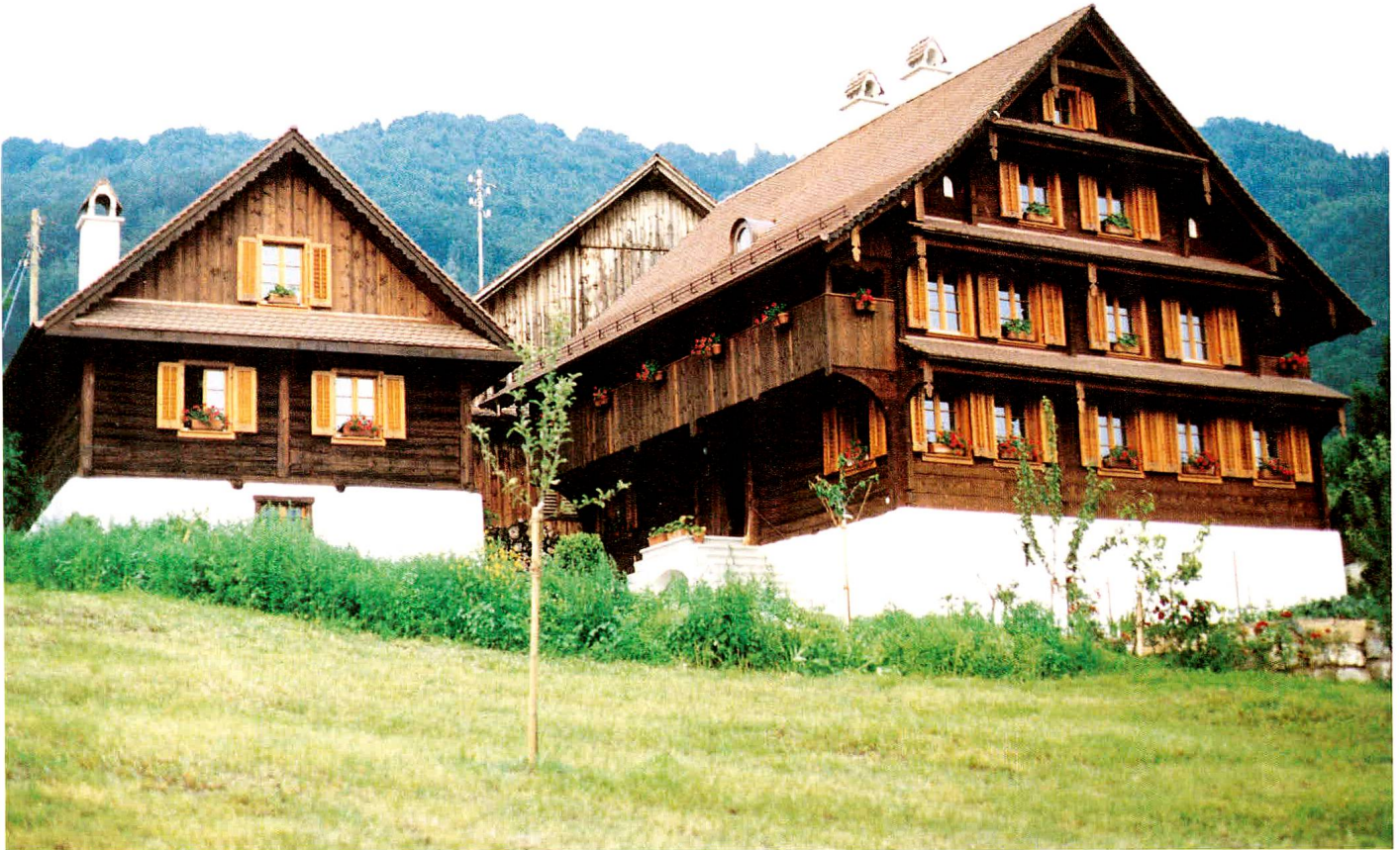
Abb. 20 Walchwil, Bauernhaus Chilchmatt. Wohnhaus und Brennütte von Süden, nach der Restaurierung, 1992.
