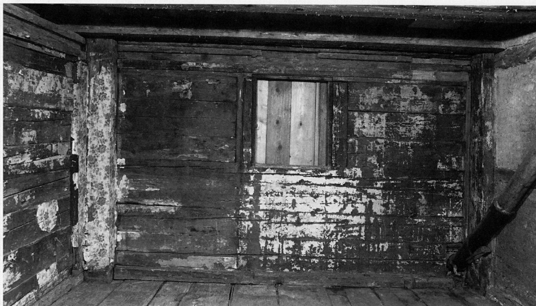
Abb. 19 Cham, Haus Obermühle, 1. Obergeschoss, Nordwest- Raum. Blick auf die West- wand mit dem zugesetzten Originalfenster. Links im Bild der dendrotatierte nördliche Mittelständer der Westfassade (1591/1592), mit den mehrfach aufsitzen- den Schichten verschie- dener Tapeten; nach Frei- legungsarbeiten 1990.
