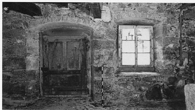
Abb. 10 Cham, Haus Obermühle. Untergeschoss, Blick Richtung Süden auf die Westhälfte der Innenseite der Süd wand; aktuelle Eingangssituation und Fenster, Zustand 1992. Leibungen mit Eckquadern aus Sandstein, mit Stichbögen aus rotem Backstein überwölbt.
