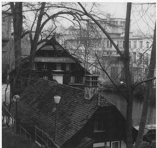
Abb. 5 Cham, Haus Obermühle. Blick von Süden, Zustand 1985.
