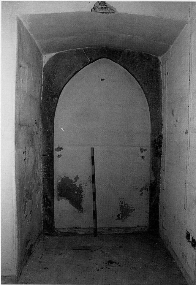
Abb. 35 Zug, Haus «beim Süßwinkel», früher Ass. Nr. 112, heute Ass. Nr. 130b. Blick Richtung Westen auf die Innenseite der Westwand. Spitzbogiger Eingang, der bei Renovierungsarbeiten Mitte des 19. Jahrhunderts vermauert wurde und bei den Umbauten des Jahres 1993 wieder eingesehen werden konnte.
