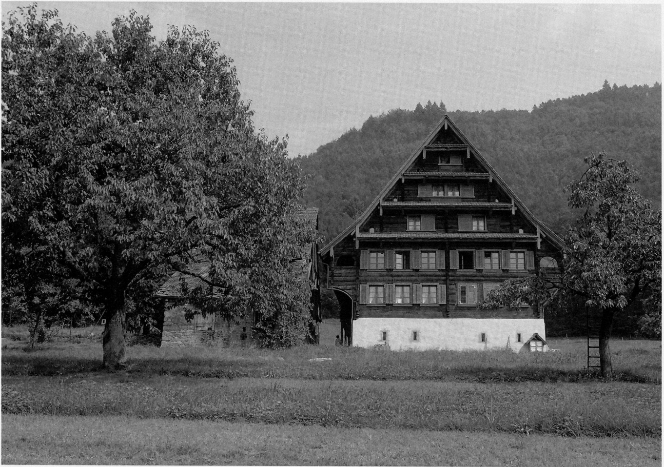
Abb. 37 Zug, Bauernhaus Otterswil nach der Restaurierung 1993.
