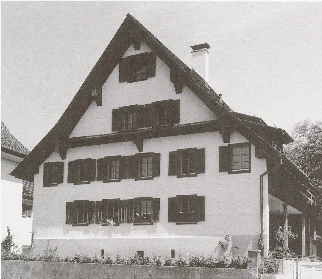
Abb. 29 Zug, Oberwil, Artherstrasse 109, Wohnhaus. Ansicht der Westfront (Strassenseite) nach dem Umbau 1993.
