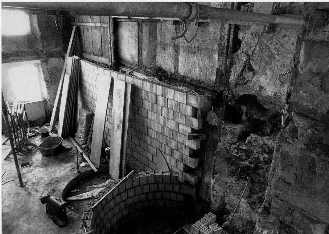
Abb. 38 Zug, Untergasse 32. Blick auf die Innenseite der nördlichen Hauswand (Trennwand zur Untergasse 30). Die überkommene Bausubstanz bleibt grösstenteils hinter der neu errichteten Wand erhalten.
