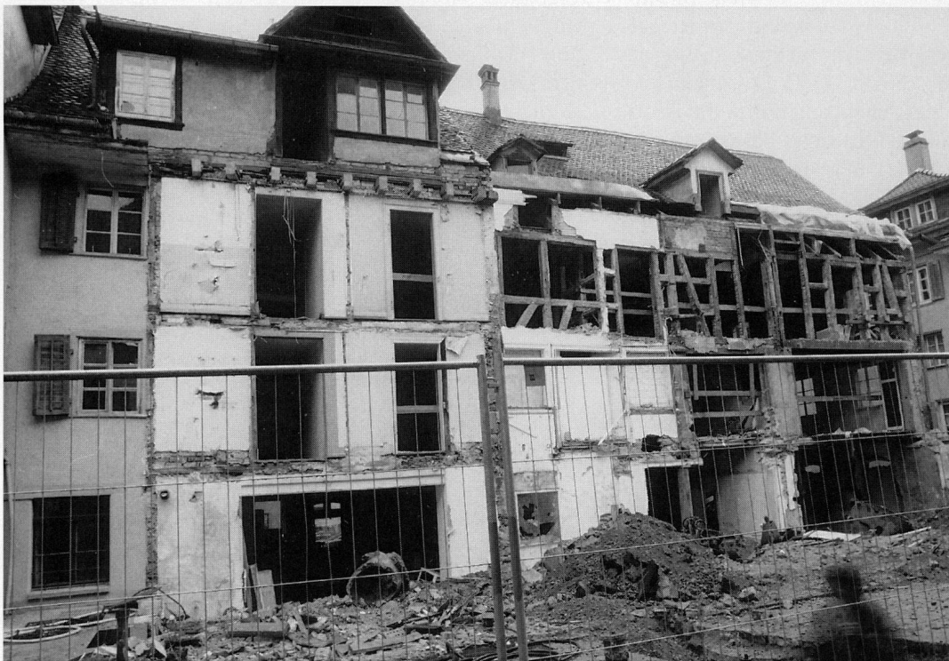
Abb. 40 Zug. Blick Richtung Westen auf die Ost-, d. h. Rückfronten der Häuser Zeughausgasse 3 und 5, erbaut nach 1795; Zustand nach Abbruch der rückwärtigen jüngeren Anbauten.
