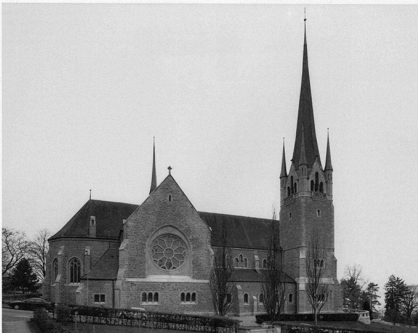
Abb. 1 Zug, Pfarrkirche St. Michael. Die Südfassade nach der Restaurierung, März 1994.
