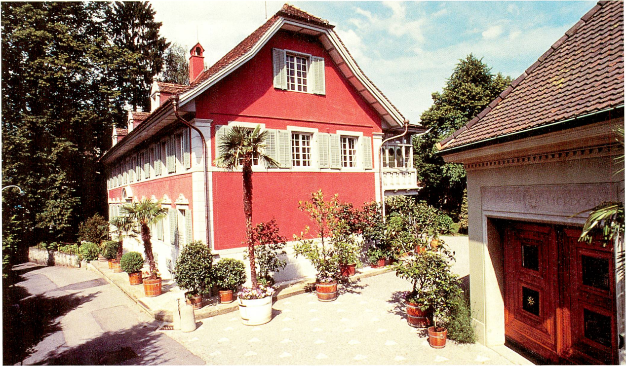
Abb. 2 Zug, Löberenstrasse 7. Das Haus «Friedheim» von Osten, nach der Restaurierung, 1994.
