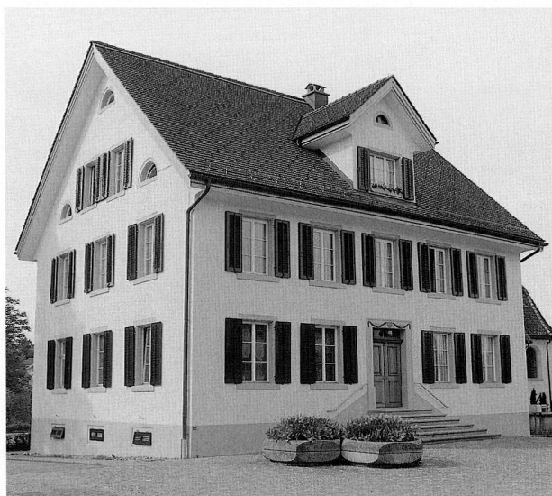
Abb. 13 Neuheim, Gemeindehaus. Ansicht von Süden nach der Restaurierung, 1994.
