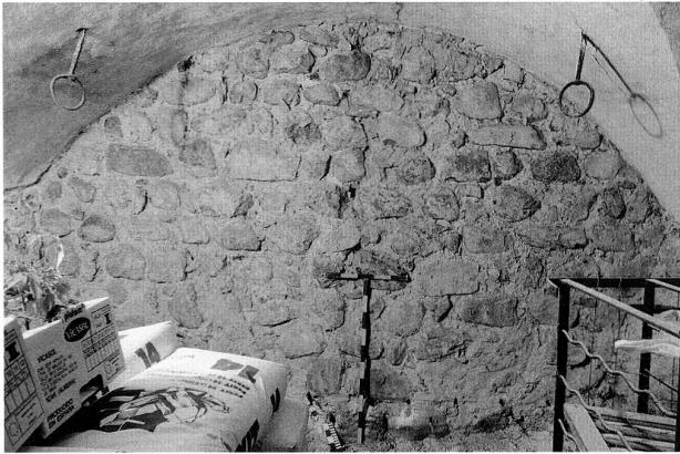
Abb. 39 Zug, Untergasse 6. «Gewölbekeller» im Südwesten des Hauses. Blick Richtung Süden auf die Innenseite der Südwand mit ihrem zumeist lagenhaften Bollensteinmauerwerk.
