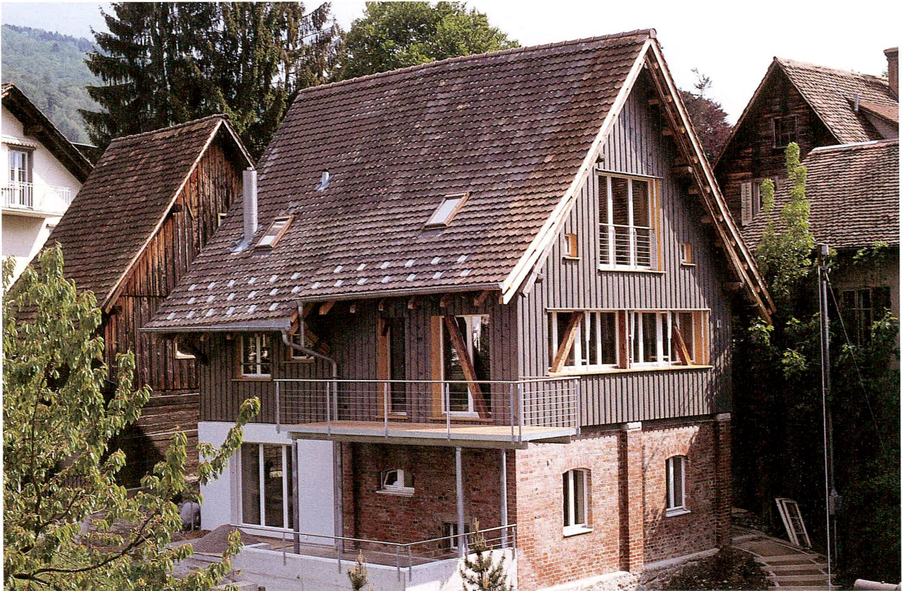
Abb. 24 Zug, Bohlstrasse 9a. Die ehemalige Scheune nach der Restaurierung, 1995.
