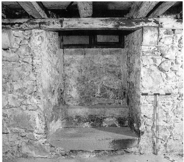
Abb. 7 Zug, St.-Oswalds-Gasse 16/18. Keller im Haus Nr. 16, Blick Richtung Norden an die Innenseite der Nordwand, während der Untersuchung 1993. In der rechten Bildhälfte ist die unterschiedliche Mauerstruktur von oberem und unterem Wandteil sichtbar. Im oberen Teil haben sich Konsolsteine erhalten. In der Wand war ein sekundär eingebrochener Eingang vorhanden, der nachträglich zu einem Fenster verkleinert worden ist. Länge der stehenden Messlatte 1 m.
