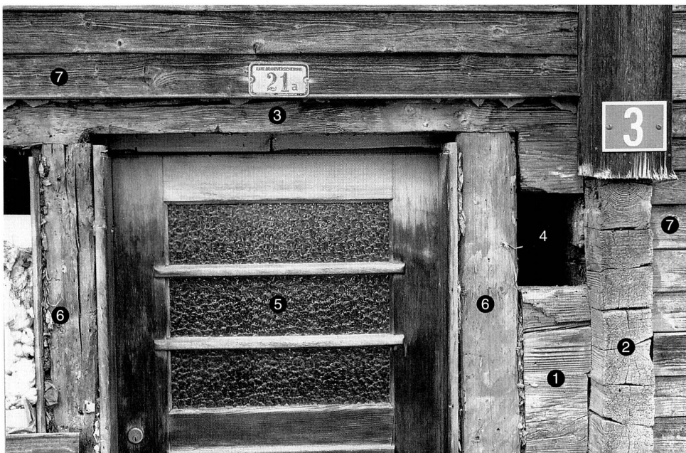
Abb. 4 Menzingen, «Kieferhaus». Teil der Ostfassade, Blick nach Westen. 1 Blockwand (Ostfassade). 2 Blockvorstoss der Korridorwand. 3 Originaler Türsturz mit kielbogenartiger Fase, daneben unverwitterte Stellen (Beleg für übergreifende Türpfosten). 4 Heiterloch. 5 Moderne Haustür. 6 Pfosten zur Haustür. 7 Moderne Bretterschalung.
