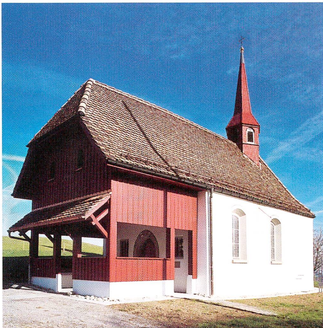
Abb. 22 Menzingen, Kapelle St. Wendelin im Stalden. Blick von Süden nach der Restaurierung, 1995.
