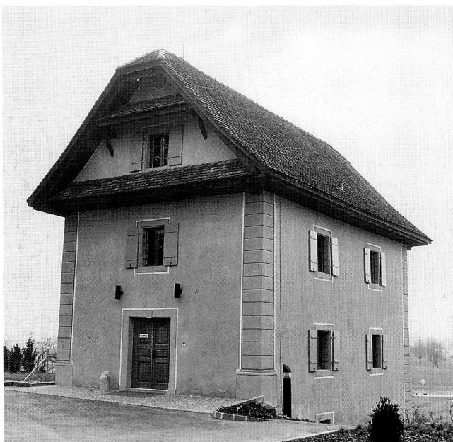
Abb. 24 Risch, Holzhäusern, ehemaliges Wasch- und Brennhaus des Katharinenhofes. Blick von Nordwesten nach der Restaurierung, 1995.
