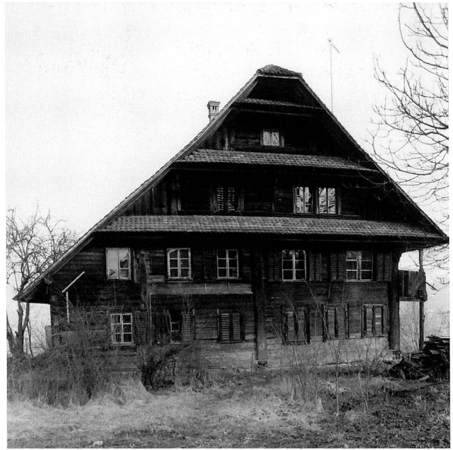
Abb. 12 Hünenberg, Burgstrasse, Haus Zum Weissen Wind. Blick Richtung Norden auf die Südfassade, Zustand 1996.
