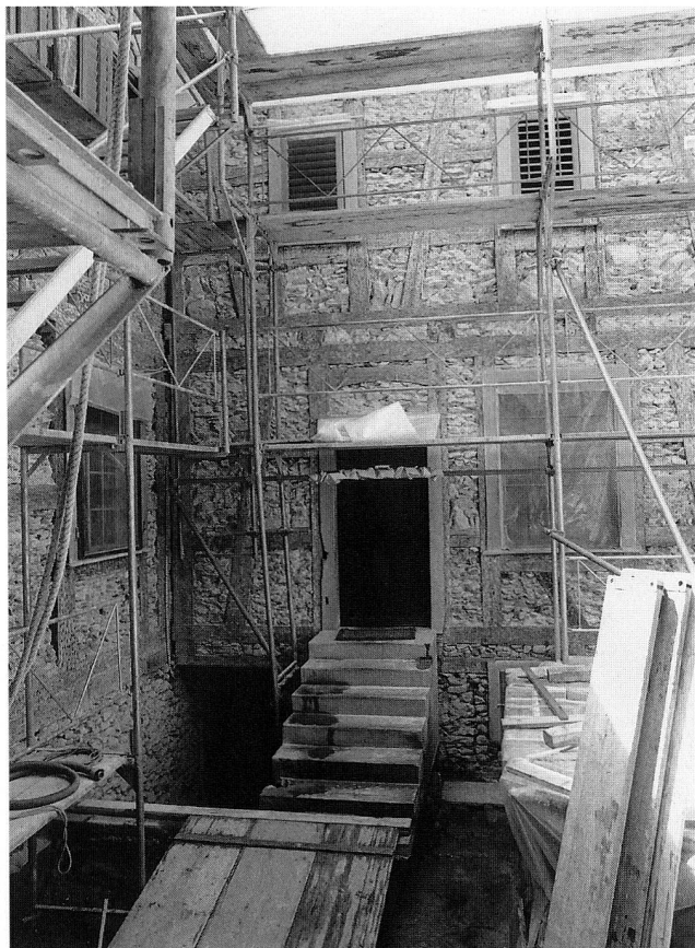
Abb. 39 Zug, Kloster Mariæ Opferung. Südwest-Ecke des Brunnenhofes während der Renovation, 1994.
