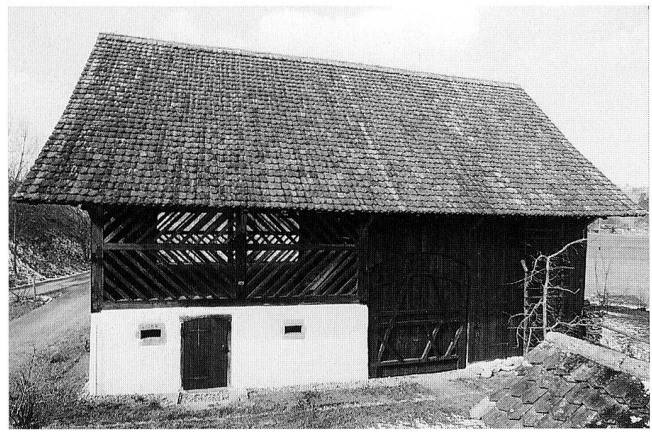
Abb. 4 Baar, Scheune Sennweid. Blick von Süden nach der Restaurierung, 1995.
