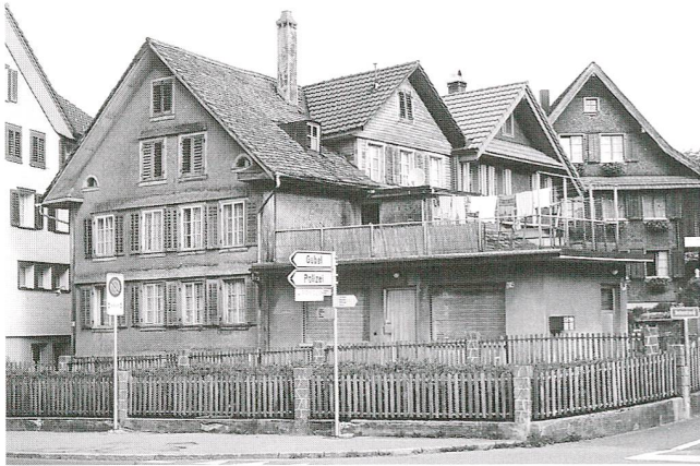
Abb. 20 Menzingen, Hauptstrasse 14. Blick Richtung Nordwesten auf die Südostecke des Hauses, Zustand 1995.
