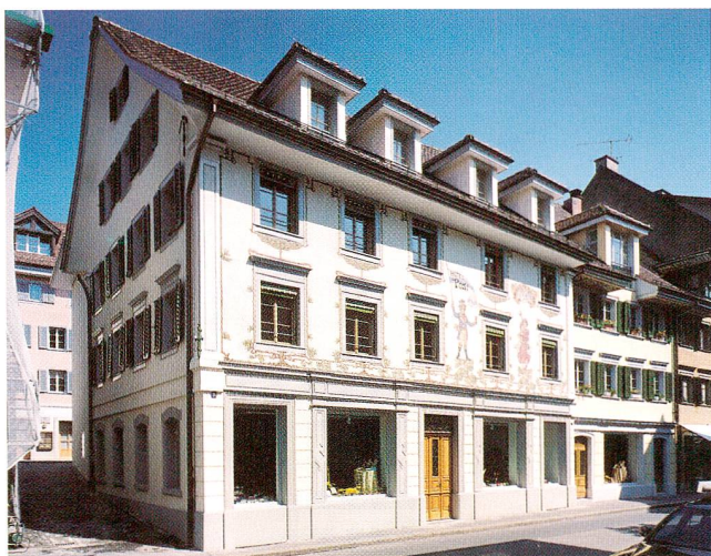
Abb. 45 Zug, Zeughausgasse 3, ehemaliges Hotel Post. Hauptfassade nach der Restaurierung, 1995.
