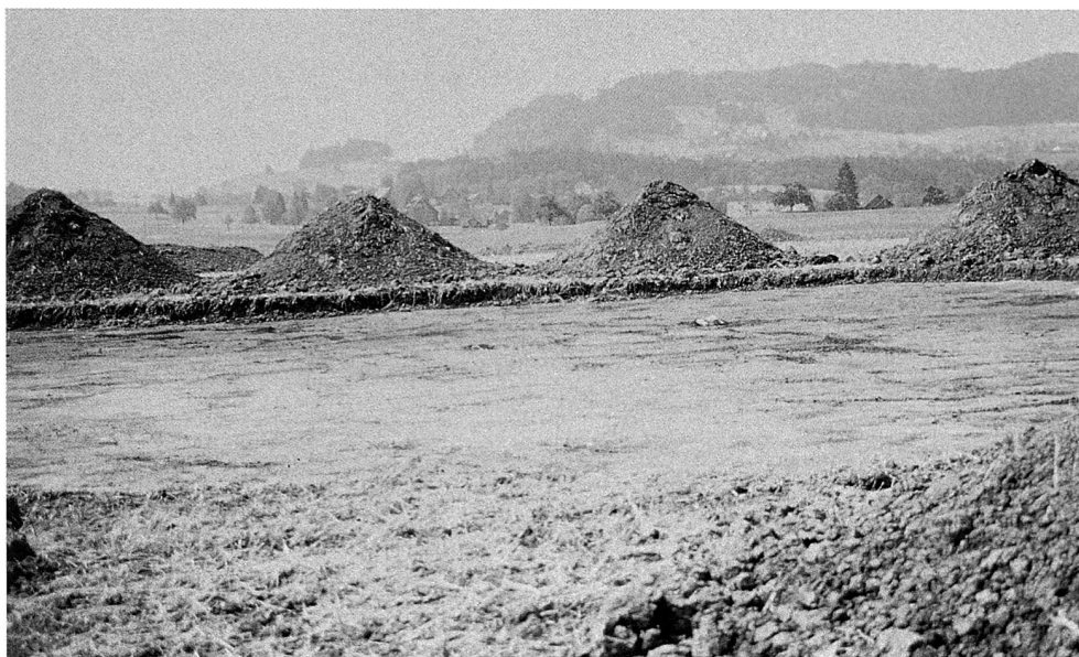
Abb. 1 Risch, Holzhäusern. Die Arbeiten für den Golfplatz hatten eine grossflächige Neugestaltung des Geländes zur Folge.
