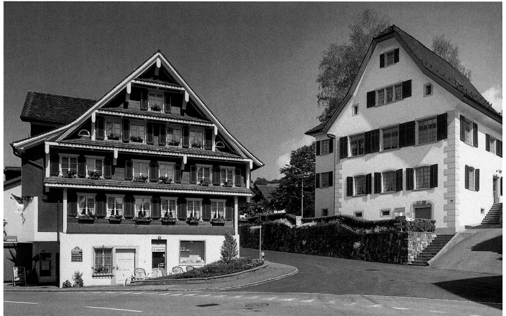
Abb. 14 Oberägeri. Das Wirtshaus Rössli (links) nach der Restaurierung 1997.
