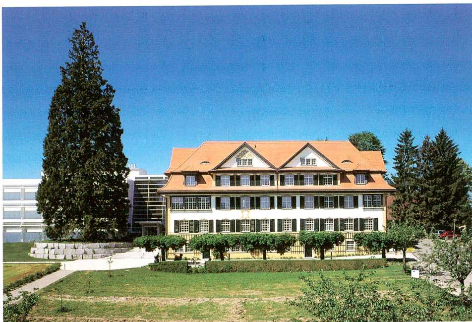
Abb. 6 Cham. Das alte Asyl nach der Restaurierung 1997. Links zurückgestaffelt die neuen Spitalbauten.
