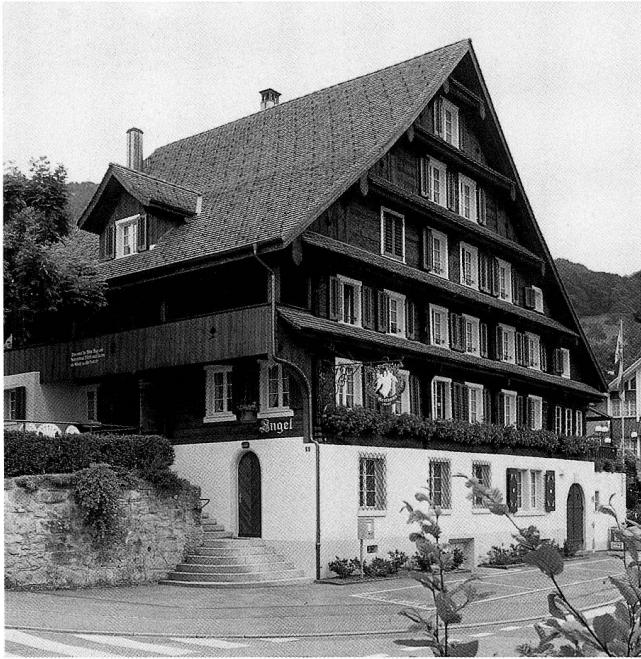
Abb. 23 Walchwil. Der Gasthof Engel nach der Restaurierung 1996.
