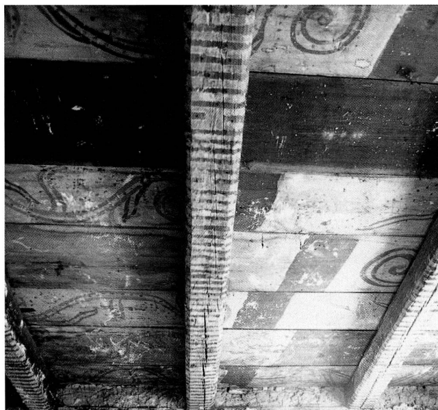
Abb. 35 Stadt Zug, Zeughausgasse 20. Übersicht der Decke des Südwest- Raumes im 3. Obergeschoss mit Malereien auf den Deckenbrettern; freigelegter Zustand 1995.
