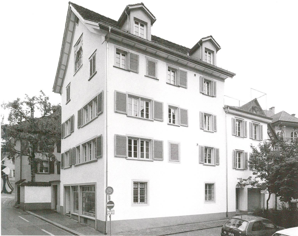
Abb. 36 Stadt Zug, Das Haus Zeughaus- gasse 20 nach der Restaurierung 1997.
