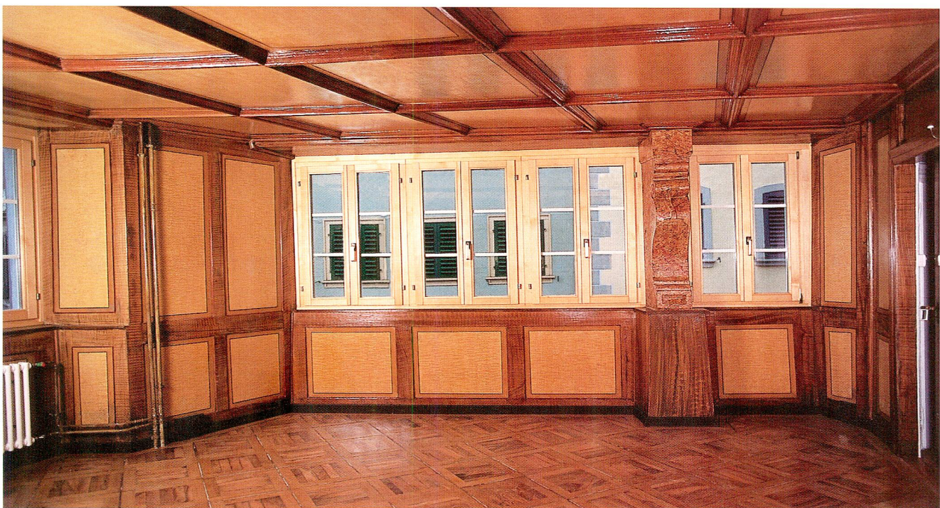
Abb. 37 Stadt Zug, Zeughausgasse 20. Die Täferstube nach der Restaurierung 1996.
