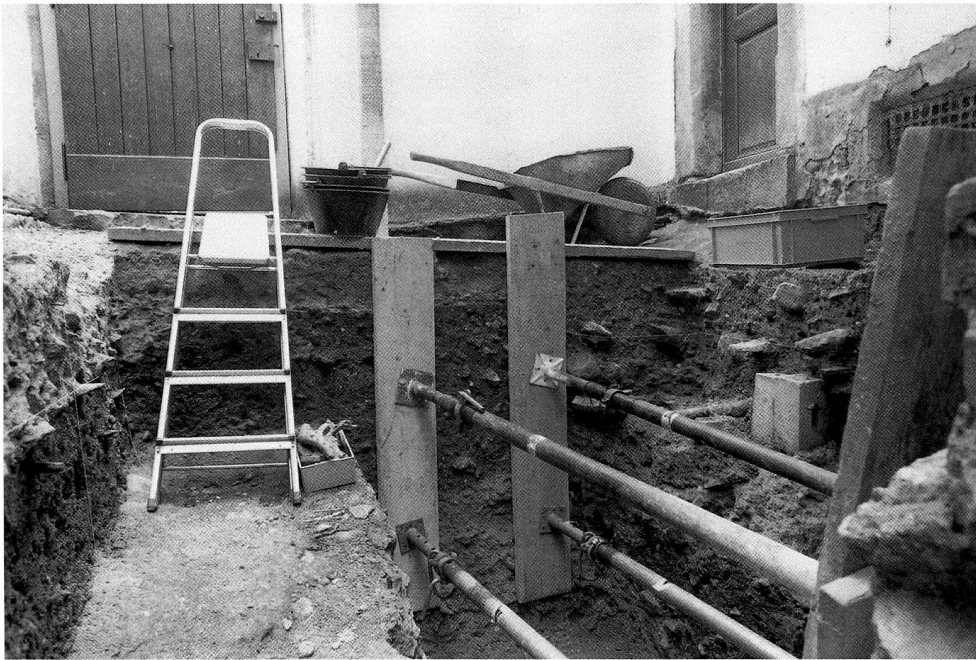
Abb. 30 Stadt Zug, Kolinplatz 6. Blick Richtung Nordosten in die überaus schwierige und enge Grabungssituation. Rechts unterhalb der Versprießung sind die noch weiter nach unten ziehenden Schichten der Stadtgrabenverfüllung zu erkennen. Die eigentliche Grabensohle konnte nicht erreicht werden.
