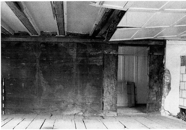
Abb. 12 Oberägeri, Hauptstrasse 1. Erdgeschoss, gute Stube, Südwand. Erkennbar sind die Pfosten der Originaltür sowie ganz rechts ein jüngerer Ofen.
