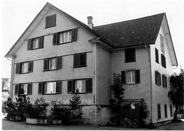
Abb. 9 Oberägeri, Hauptstrasse 1. Blick Richtung Osten, Zustand 1993.
