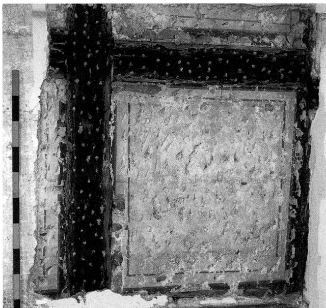
Abb. 34 Stadt Zug, Zeughausgasse 20. Blick Richtung Osten auf eine Fachwerk- wand des Nordwest-Raumes im 3. Obergeschoss mit Malerei; freigeleg- ter Zustand 1995. Einteilung der Messlatte in 10 cm.
