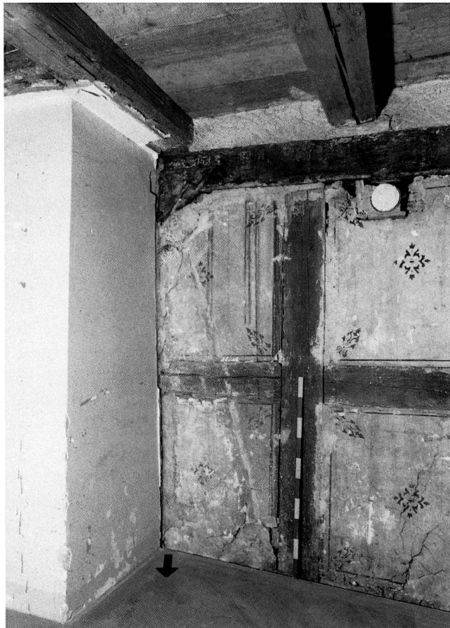
Abb. 26 Stadt Zug, Ägeristrasse 15. Zweites Obergeschoss, Nordraum des Hauptbaues. Schablonenmalerei. Links oben ist ein Kopfholz zu sehen, das den Spannbalken mit dem (links verdeckten) Ständer verbindet.
