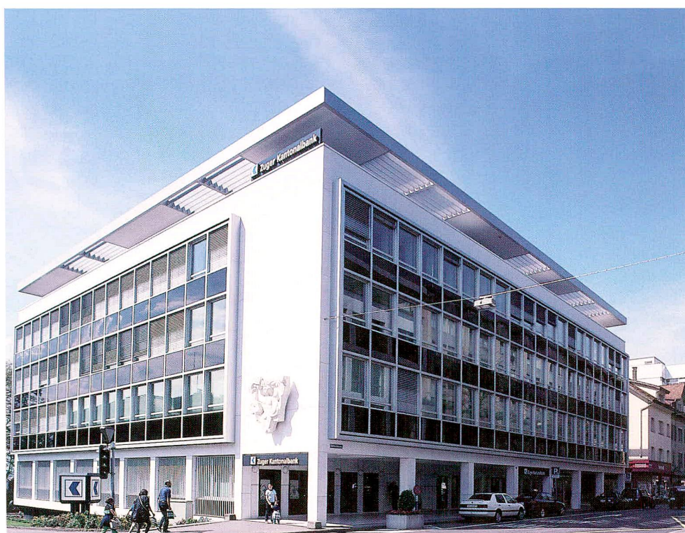
Abb. 12 Zug, Hauptsitz der Zuger Kantonalbank am Postplatz nach der Restaurierung 1997.
