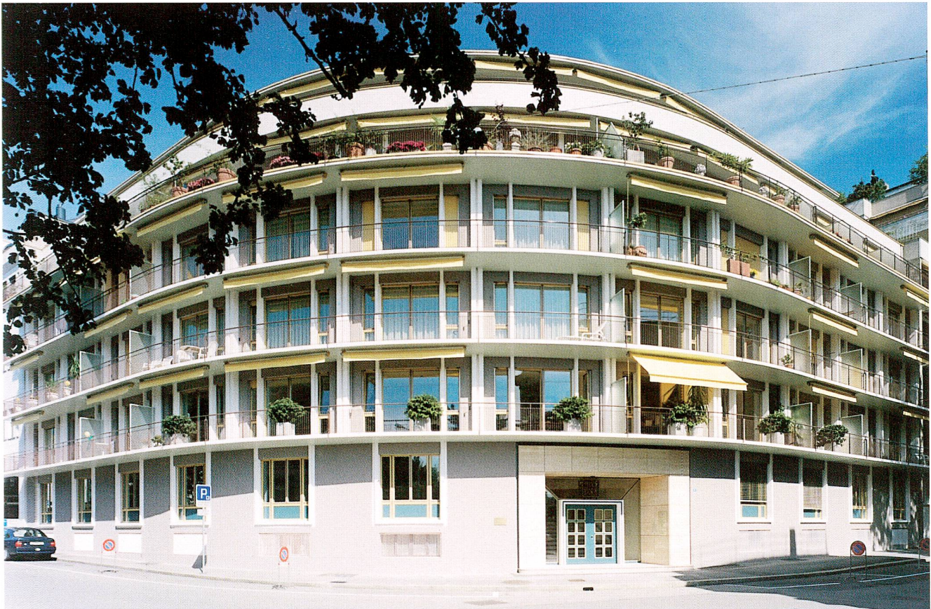
Abb. 5 Zug, Appartementhaus «Seepark». Ansicht der Hauptfront nach der Restaurierung 1997.
