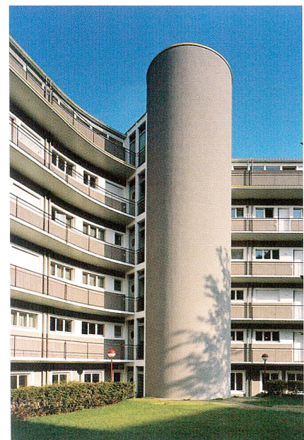
Abb. 6 Zug, Appartementhaus «Seepark». Ansicht der Hoffassade mit dem Treppenturm und den Laubengängen, nach der Restaurierung 1997.
