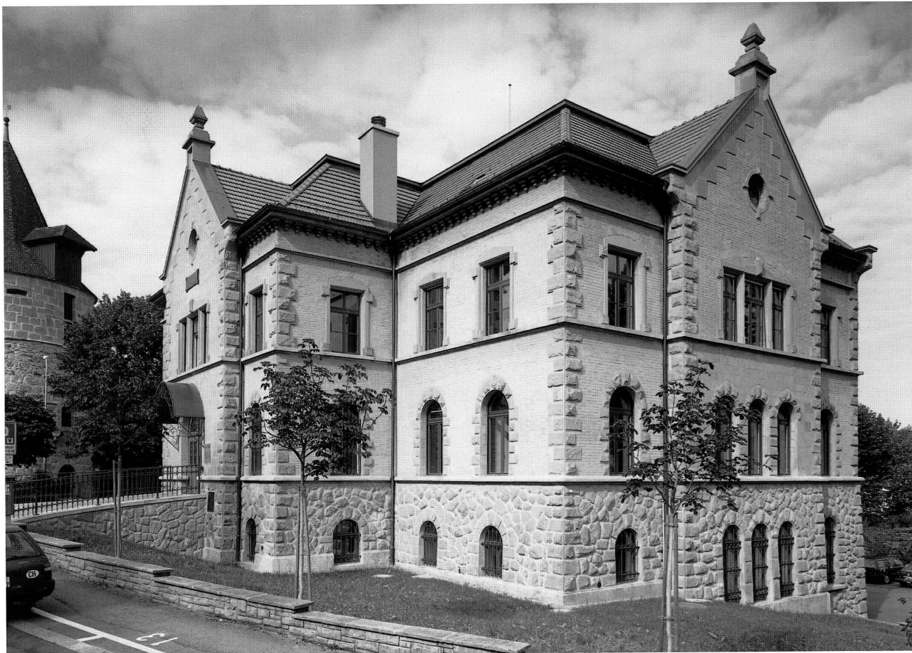
Abb. 39 Zug, Kantonales Zeughaus. Zustand nach der Restaurierung 1997.
