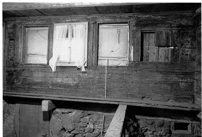
Abb. 14 Menzingen, Blumenweg 4. Erdgeschoss, nach bauseitigen Freilegungsarbeiten und Entfernen der Decke gegen den Keller. Nordwand (Innenseite) des ursprünglichen Blockbaues aus der Mitte des 15. Jahrhunderts. Rechts ein zugesetztes Originalfenster, links der Ansatz eines weiteren Originalfensters neben dem jüngeren Fenster.
