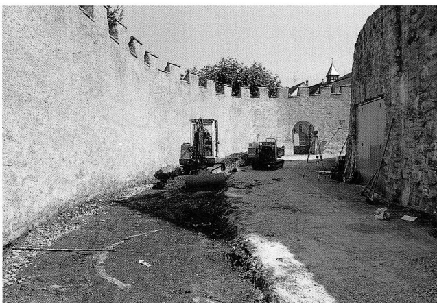
Abb. 28 Zug, Graben der ehemaligen Burg. Der Blick in Richtung Nordosten zeigt im Vordergrund den Rest eines Kreises aus Backsteinen als Einfassung einer Wasserkunst, nach 1774.
