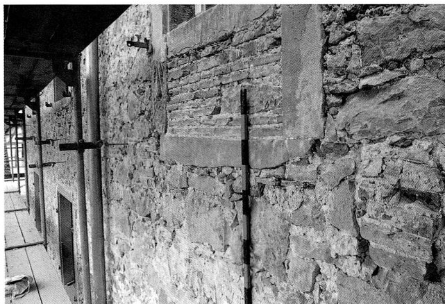
Abb. 22 Obergeschoss des Osttraktes, Aussenseite. Eine Tür führte hier zunächst in eine vor der Aussenfassade liegende Toilette. Diese ist als Holzkerker o. ä. zu rekonstruieren, wie die mit Backsteinen zugemauerten Balkenlöcher (rechts) belegen. Nachträglich wurde diese Tür im unteren Teil zugemauert und als Fenster weiterbenutzt. Einteilung der Messlatte in 10 cm.
