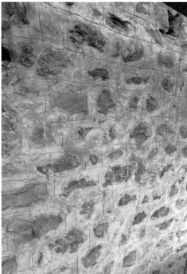
Abb. 8 Romanisches Mauerwerk an der Kirchenostwand mit zugehörigem Pietra-rasa-Verputz mit Fugenstrich. Übersicht.
